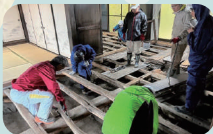
想家プロジェクトの空き家修繕ワークショップ
